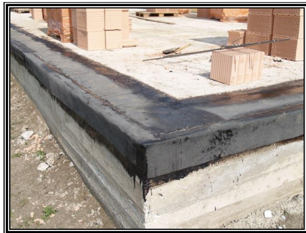
Hotový připravený základ
