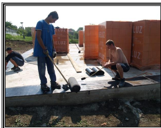
Přilepování hydroizolace
